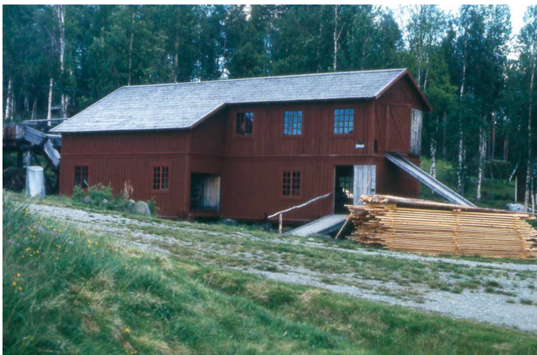
FIGUR 3. Sågverket vid Torvsjö kvarnar i Lappland utanför Vilhelmina. Torvsjö by anlades som ett nybygge 1752. Vid kvarnbäcken fanns 1876 fem kvarnar, två logar och en såg. Anläggningarna var i drift till ca 1950 och utsågs, som den andra av landsbygdens industrimiljöer, till byggnadsminne 1972. FOTO: Gert Magnusson.
