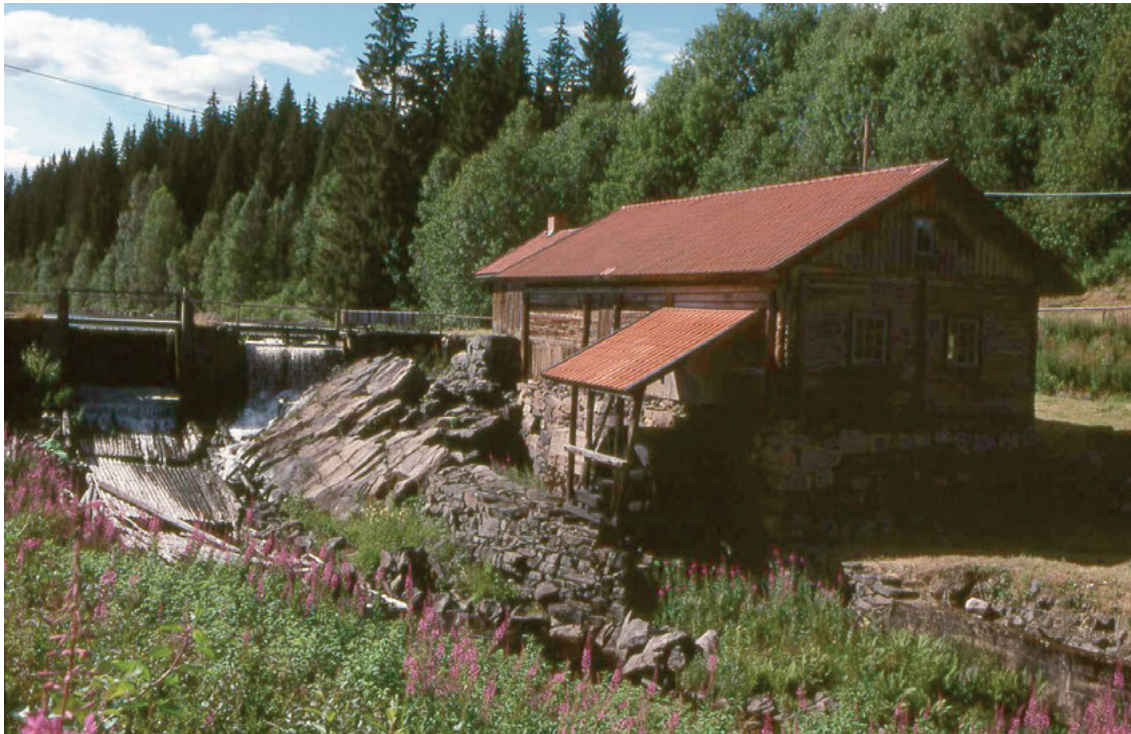
FIGUR 4. Rödåfors kvarn i Östmark byggdes 1859 och var i drift till 1960. Kvarnen består av två par kvarnstenar drivna av var sitt vattenhjul och är typisk för vattendrivna kvarnar i Värmland. Byggnadsminne 1971. FOTO: Gert Magnusson.
